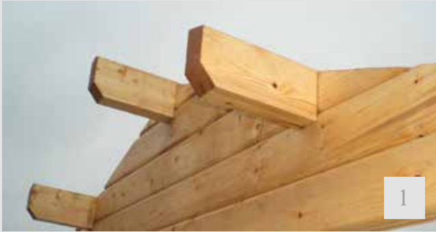
Bild 1 Außenansicht Giebel mit Dachüberstand Sämtliches Dachholz wird kesseldruckimprägniert geliefert.
